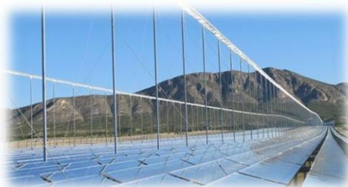
Solarthermische Anlagen können dabei eine zentrale Rolle übernehmen und maßgeblich zur Energieversorgung beitragen. Am Beispiel eines Fresnelkraftwerks untersucht ihr, wie Sonnenstrahlen optimal genutzt werden und entwickelt dazu eigene Optimierungsverfahren.
